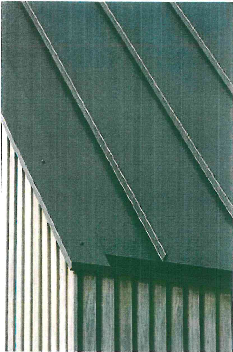
Kastenrinne verdeckt Fallrohr bündig mit Fassade
